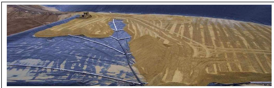
*Vue de la réalisation d'un réseau de drainage des lixiviats en fond de casier*
