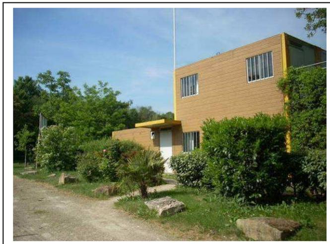
*Exemple type d'une construction modulaire revêtue d'un bardage bois*
